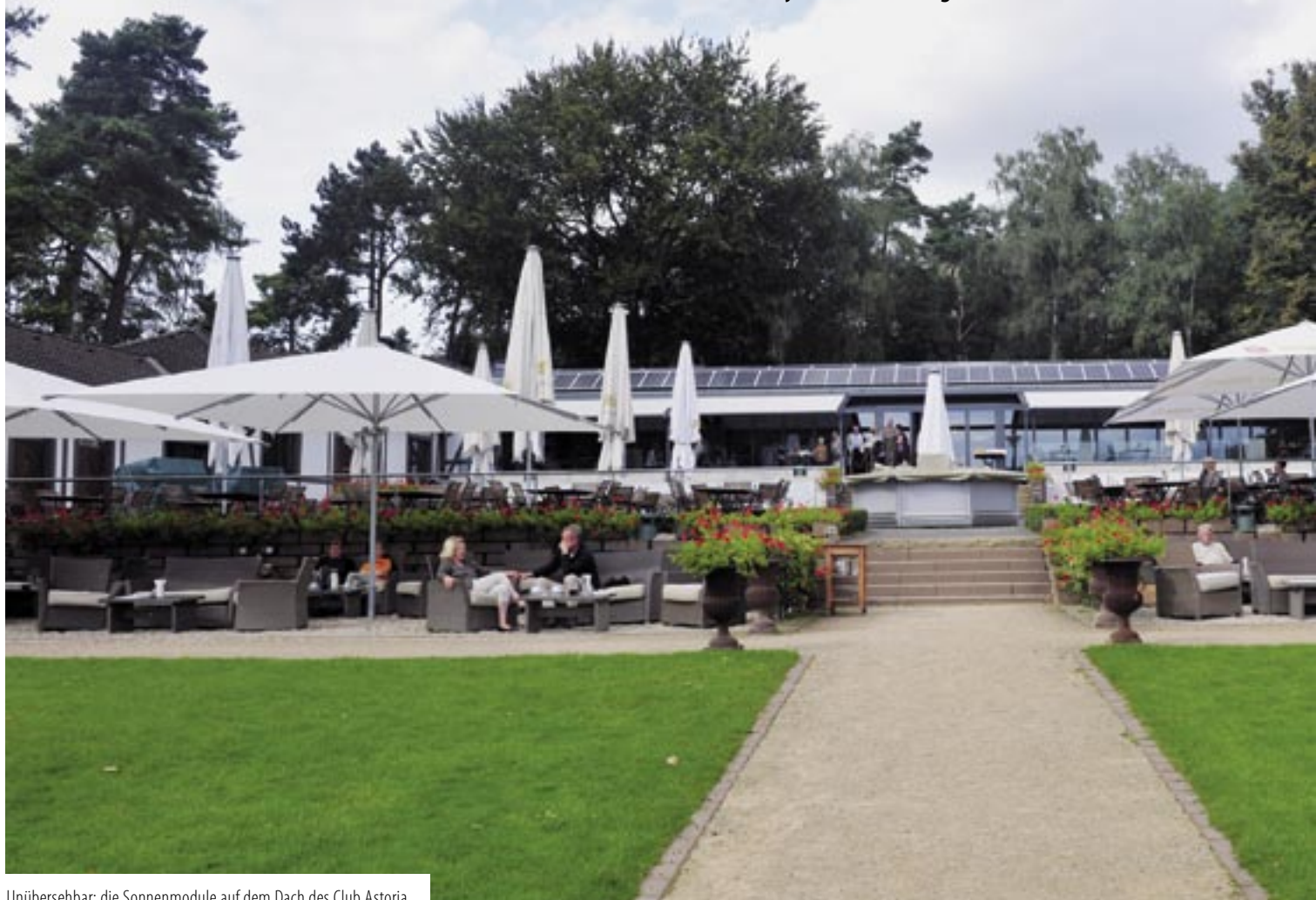
Unübersehbar: die Sonnenmodule auf dem Dach des Club Astoria
